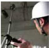
受光器のリモコン機能で墨出し器のラインの消灯・点灯ができます。(消灯モード) 高所用三脚を使用している場合など、いちいちレーザーを上げ下げする必要がありません。再点灯時には消灯時のラインパターンを再現します。リモコンでのライン切替・モード切替も可能です。
