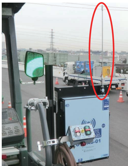
(写真の重機は、VÖGELE Super 2100-3iです。)
