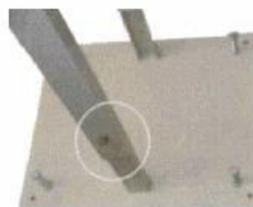
5. 支柱の取り付け
