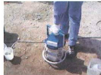
作動弁を引き上げる
