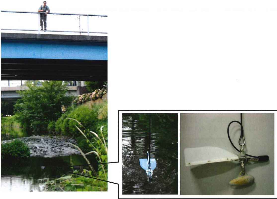
図3 ベーンセット（オプション）による橋上測定
