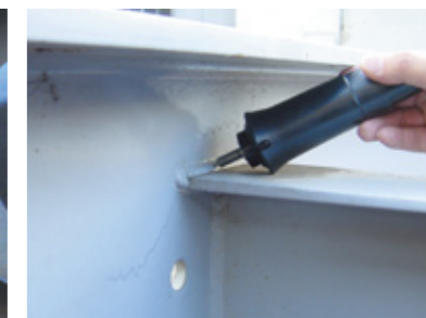
● 溶接部の溶接強度測定 (引張強度の確認)
