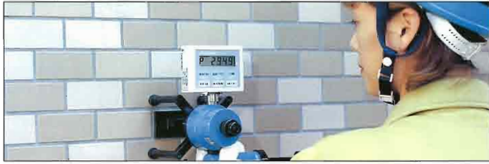
(外装タイル接着強度測定)
