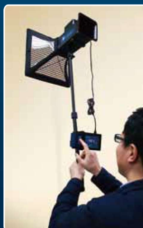
空調機器の点検・調整に
