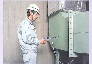
ダクト内静圧測定 (オプション)
