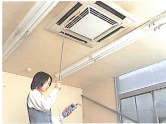
空調設備のメンテナンスや検査
