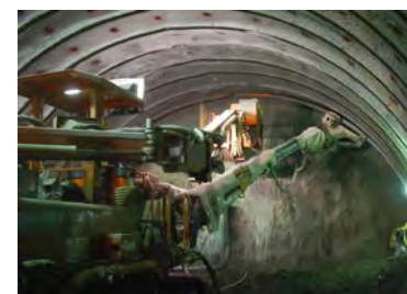
支保工建込み状況
