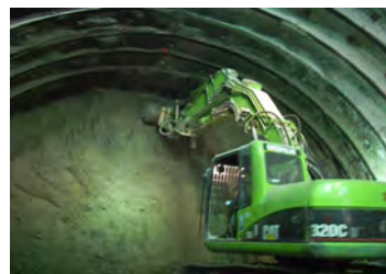
機械掘削状況
