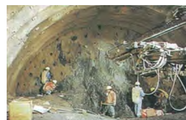
発破掘削状況
