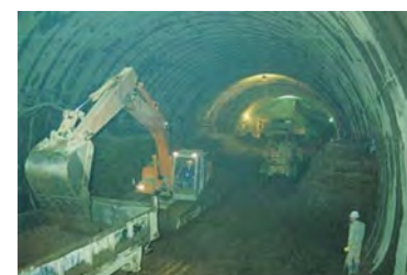
ずり出し状況(ダンプトラック式)
