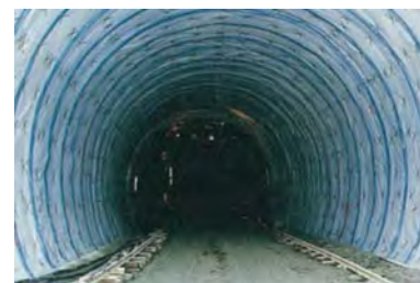
防水シート張り状況
