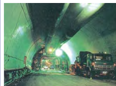
二次覆工コンクリート打設状況
