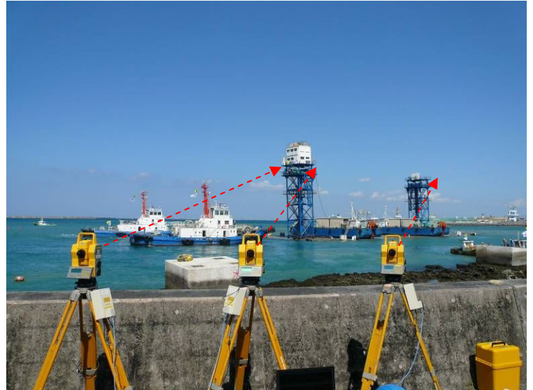
沈埋函据付への適用事例
