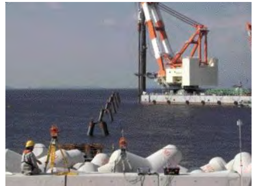
杭打設への適用事例
