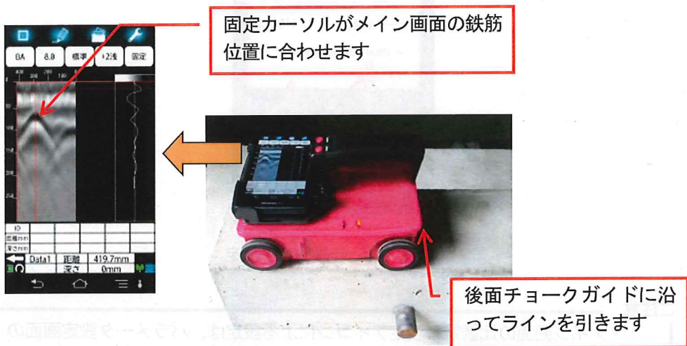
図 6-6 前進探査墨だし
