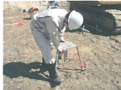
足掛け板を踏み、スパイクを貫入
