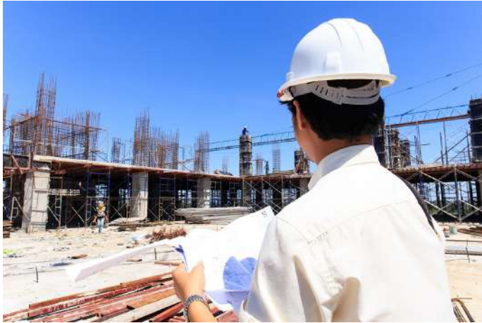
建設現場・イベント会場
