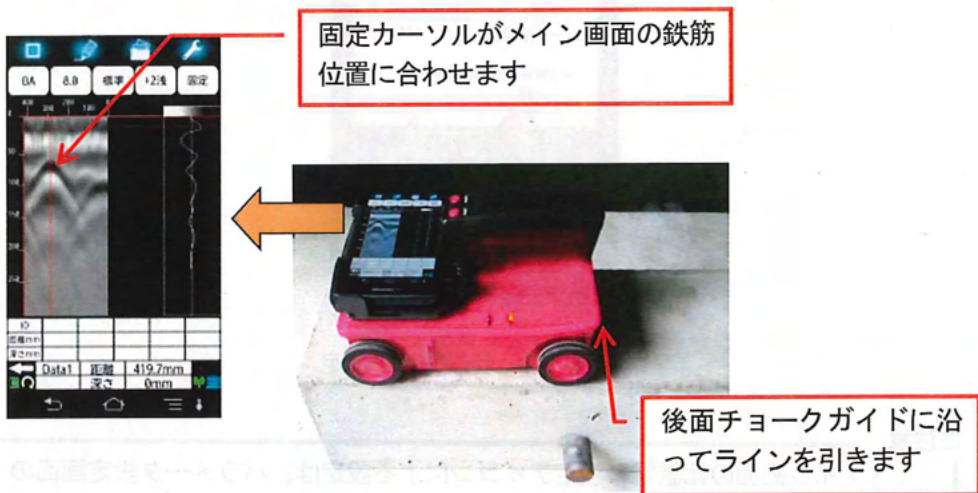
図 6-6 前進探査墨だし
