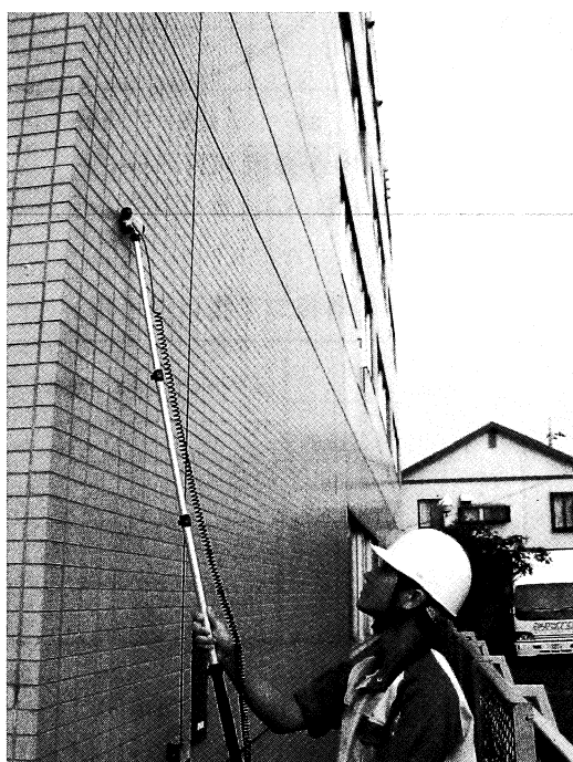
外部センサユニットを使用した測定
