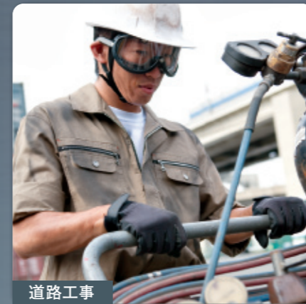
道路工事 交通整理など、見通しの効かない離れた場所との連携を実現。
