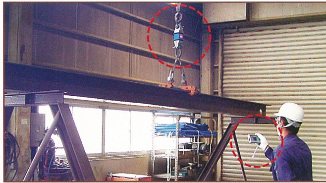
●鋼材の吊上げ機の安全管理
