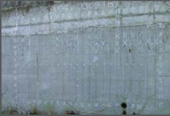
実構造物の打音検査 (x印は異常と判断された箇所)
