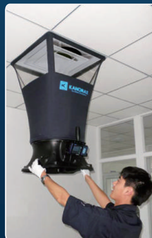
空調機器の点検・調整に
