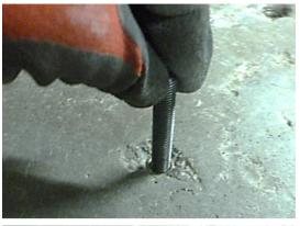
① あと施工アンカーが内ネジの場合、 適合サイズのボルトをねじ込みます。※ねじ込みが不十分であると、ボルト等の ねじ山を傷める原因となります。
