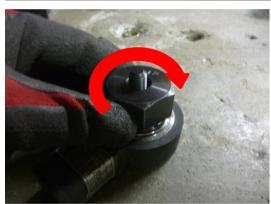
⑥ カプラを設置します。カプラを設置 する際は必ず④と⑤の説明された座金を 間に挟んでください。
