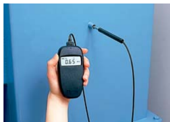
ダクト内の風量測定に…
