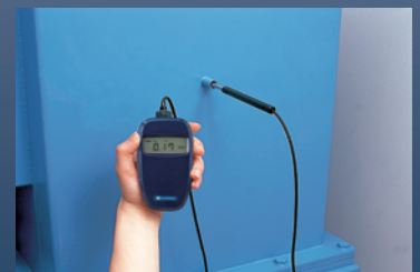
空調機器の能力試験・保守点検
