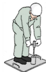
③ 打込棒の引抜き
