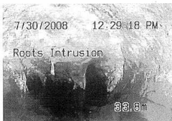
図 15 ディスプレイ画面に表示されたスライドテキスト、時刻および距離（システムゼロポイントから計測された距離）
