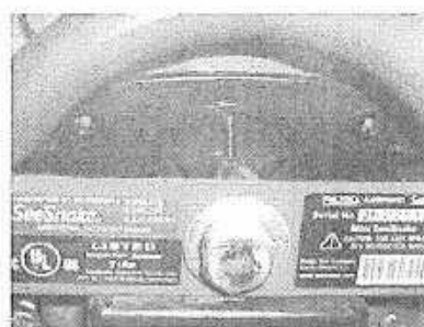
図22 取り付けられたプレート
