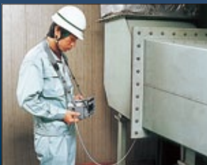
ダクト内の風速・静圧測定に
