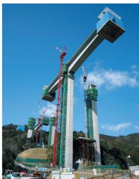
橋脚から両側に少しずつコンクリートを打設して桁を伸ばしていく工法です。バランスがとれるように両側順番に“やじろべ”のように伸ばしていきます。橋脚と橋脚の真ん中でドッキングします。高さが高い位置に桁を造る時によく使われる方法です。（桁を地面で支えることが出来ないため、空中で造っていく工法です。）
