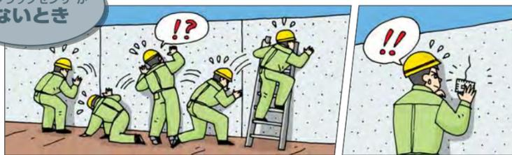
ひび割れを目視で確認し、実際にクラックスケールをあてて、ひび割れ幅を測る。
